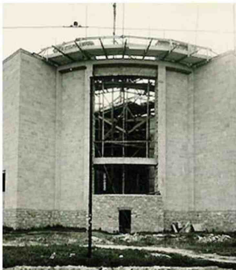
L'edificio durante la costruzione
